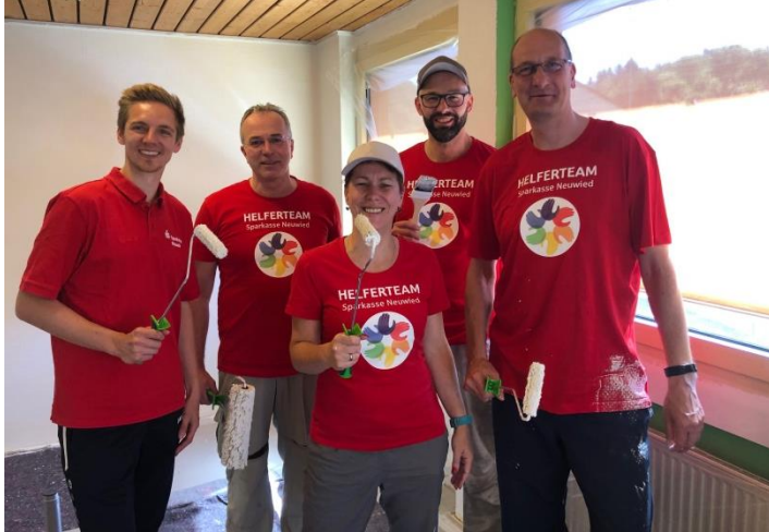
Das nächste Helfer-Team verpasste dem Turnraum des Kindergartens St. Walburgis in Leubsdorf einen neuen Anstrich.
